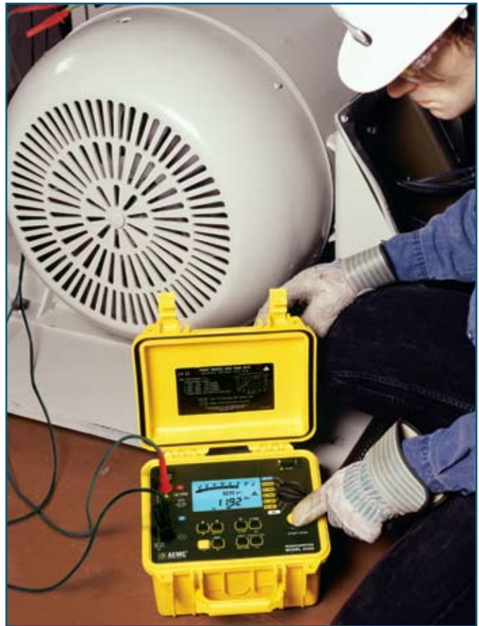
Comprobando la resistencia de aislamiento sobre los cables de alimentación de un motor trifásico con el Modelo 5060.
