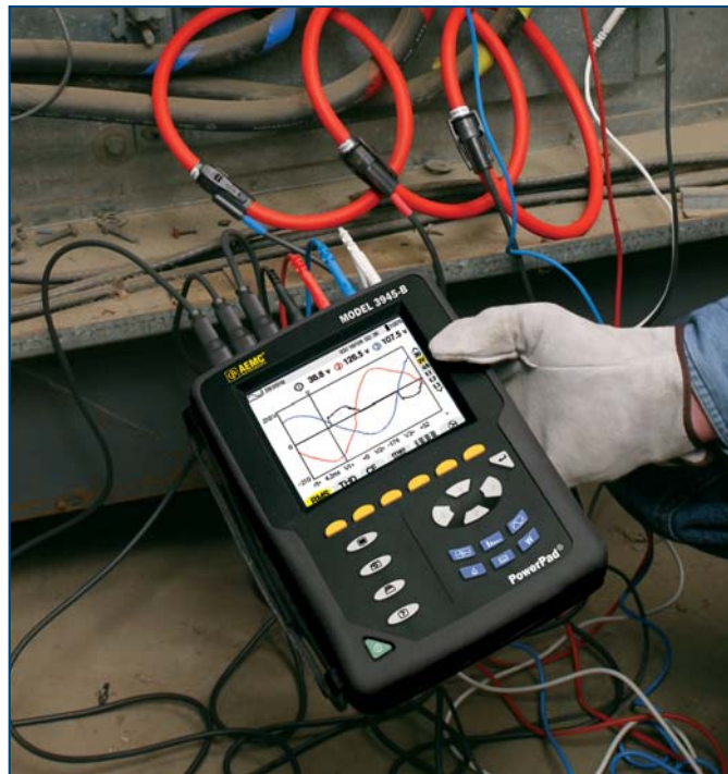
Análisis de calidad de potencia sobre un panel de tres fases utilizando las sondas de corriente flexibles AmpFlex ® .
